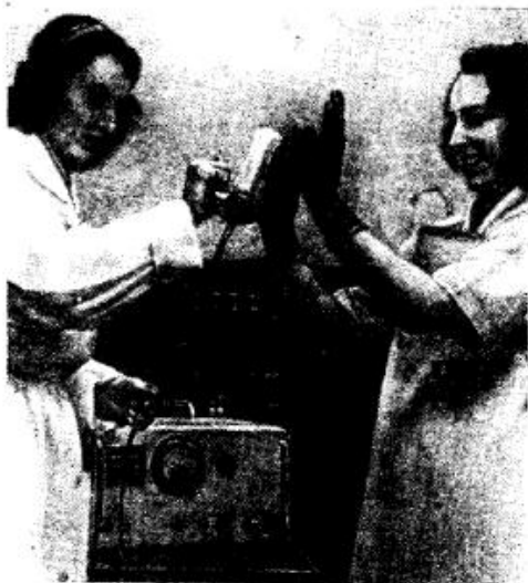
Рис. 158. Дозиметрический контроль чистоты резиновых перчаток.
